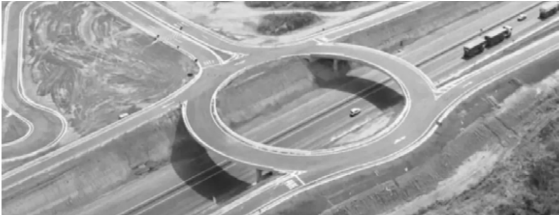
Formato circular da obra já em operação vista por cima
