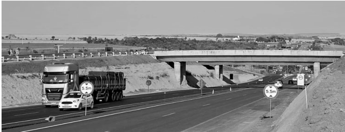
BR-020 primeiro viaduto por baixo, entregue no trecho da duplicação
