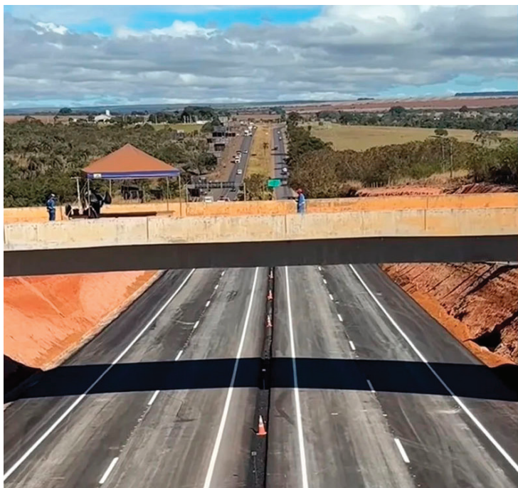
Primeiro viaduto quase pronto
