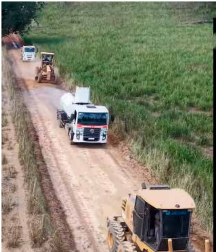
Estrutura da prefeitura nas estradas. Eficiência
