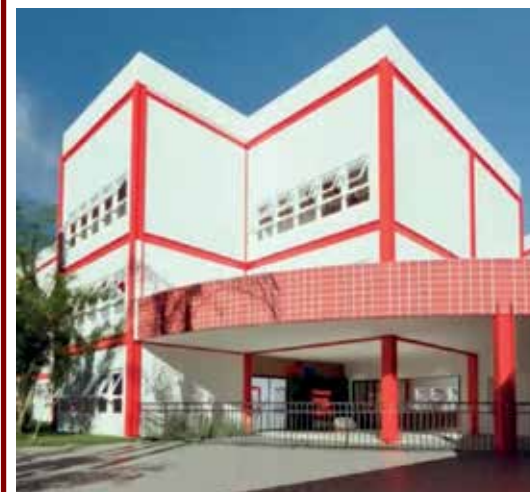
Espaço em fase final de acabamento
