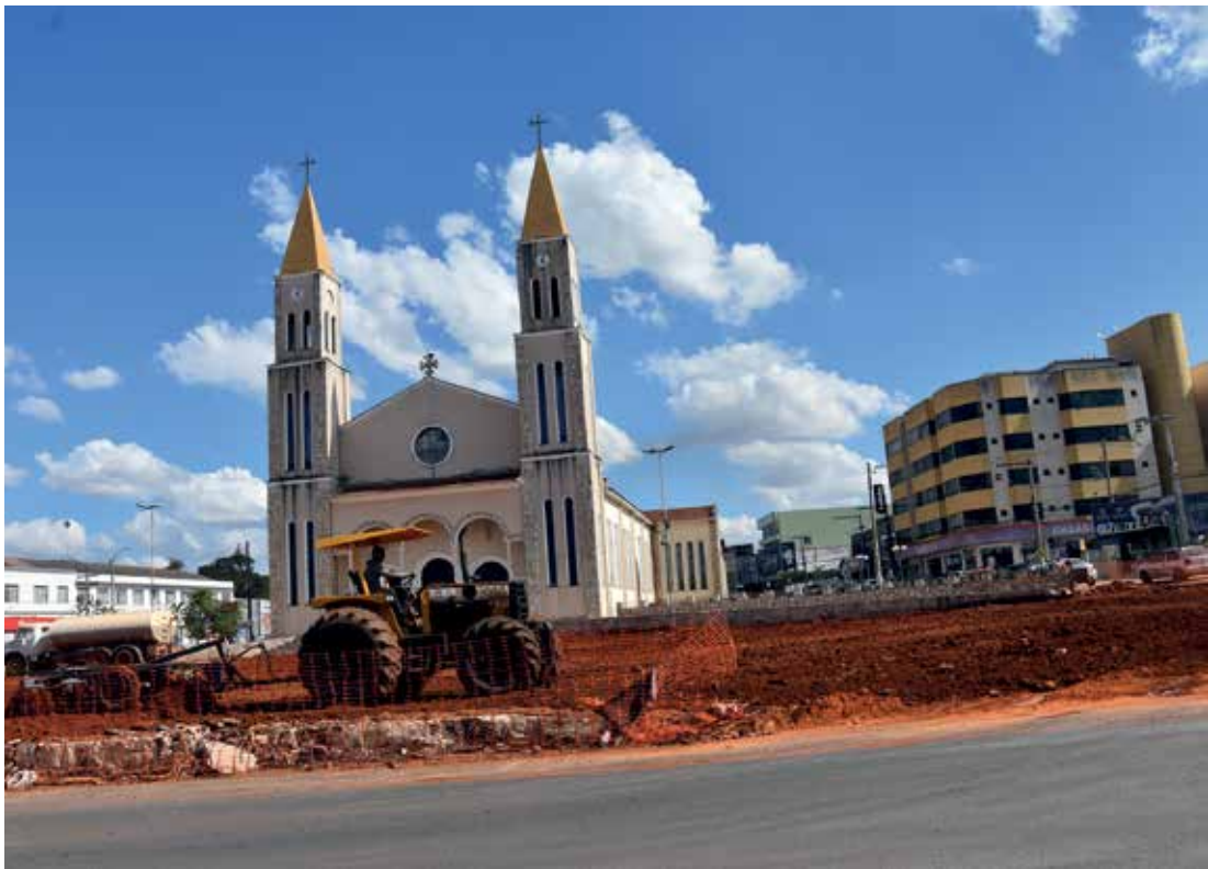
Praça em obras para receber novo projeto
