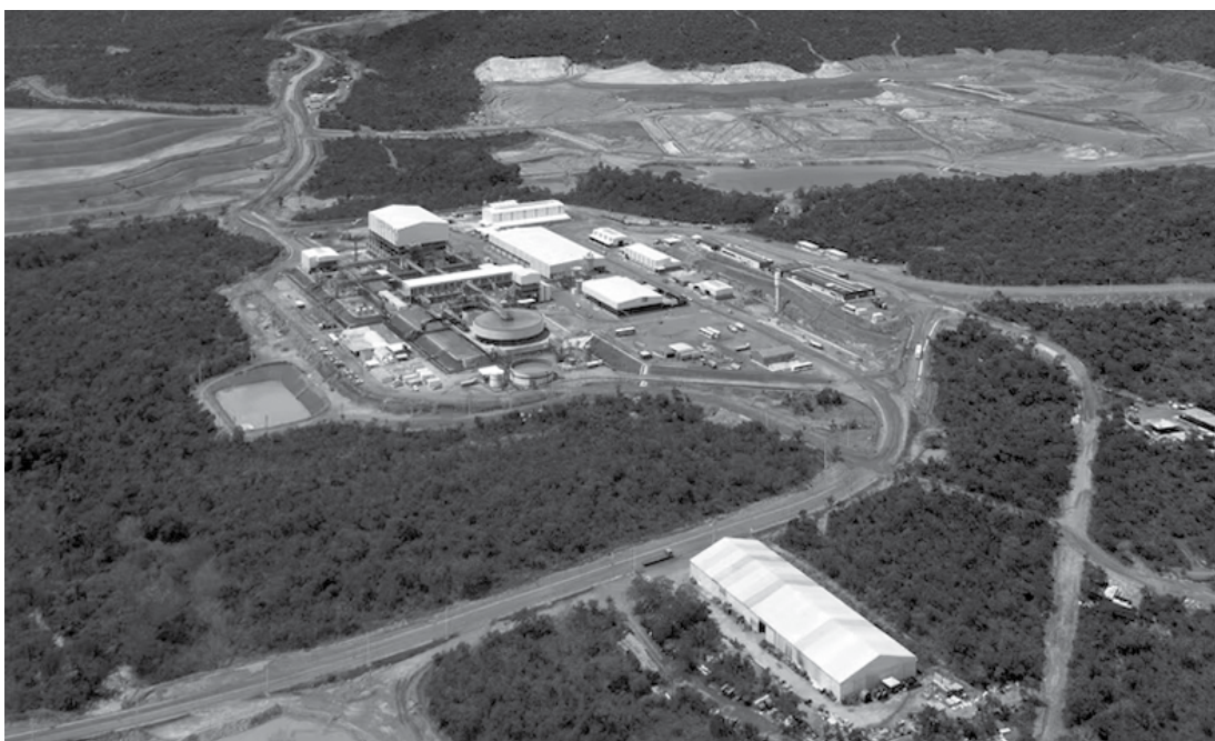
Mina instalada e funcionando em Minaçu/GO.
