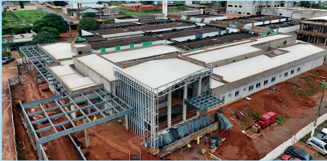
Obras da unidade hospitalar em estado adiantado
