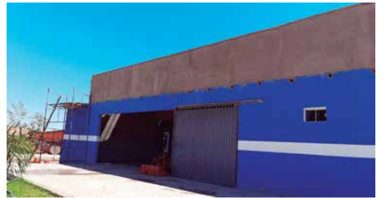
Jander: Construção ampliada
