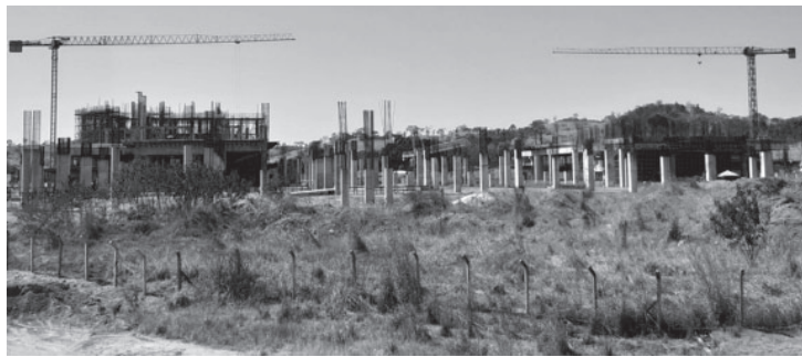
Obras do novo templo muito atrasadas
