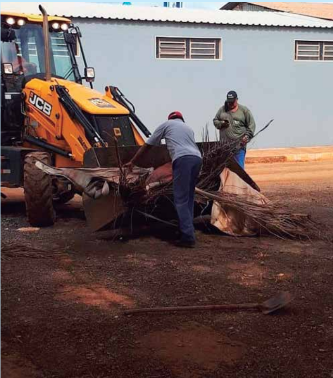
Homens e máquinas trabalhando
