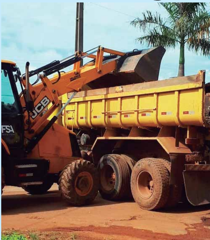
Coleta de entulho nas ruas
