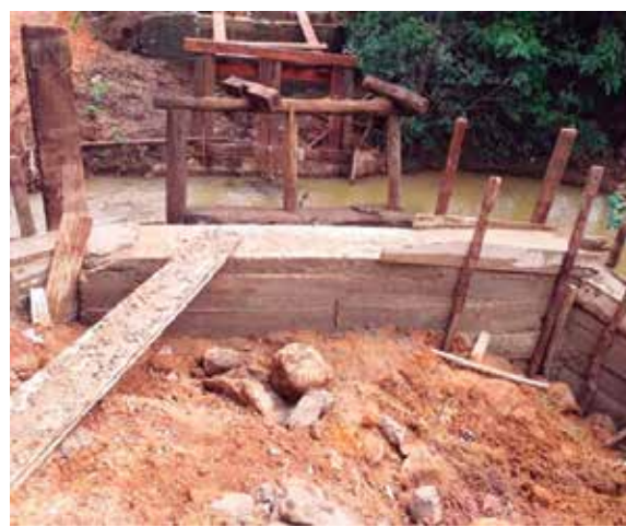
Início do trabalho de recuperação
