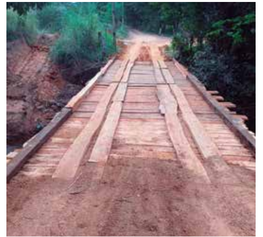
Ponte depois de pronta. Atendimento
