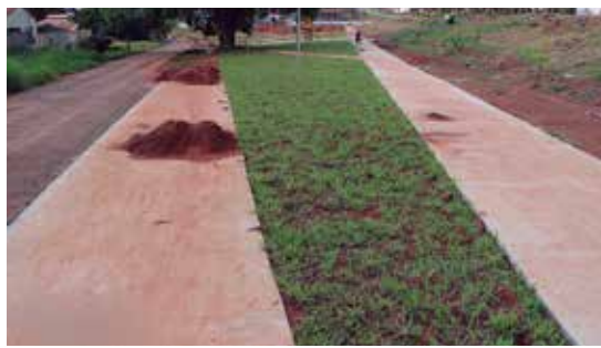
Estrutura planejada e racional
