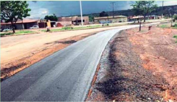
Obra toma corpo com asfalto
