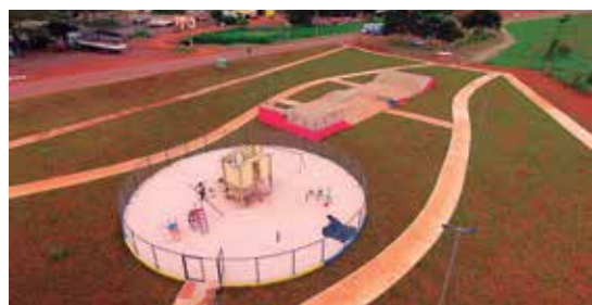
Praça do Skate. Obras estão em andamento
