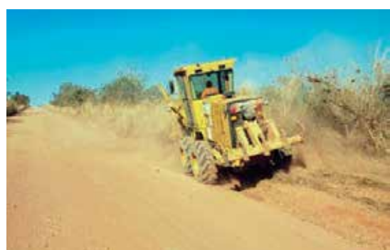
Serviços são "insatisfatórios"
