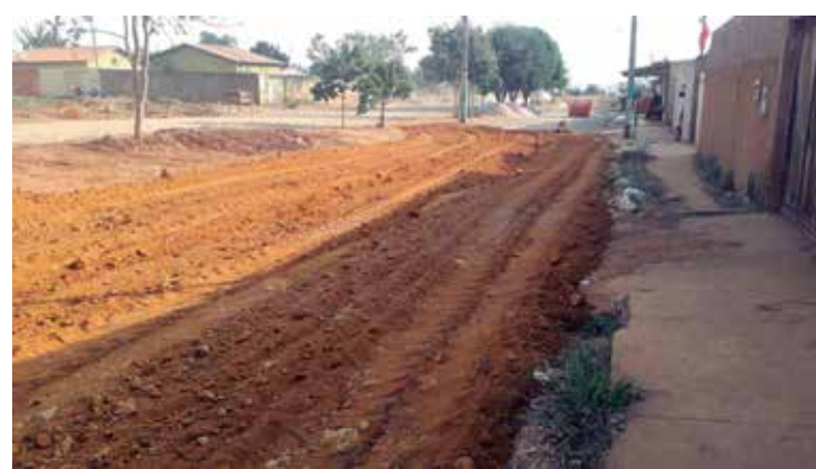
Investimentos pesados nas melhorias
