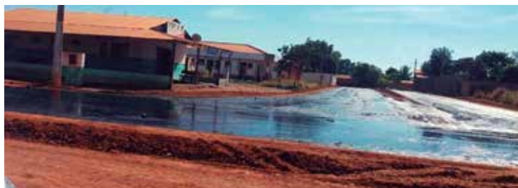
Asfalto no Setor São Pedro
